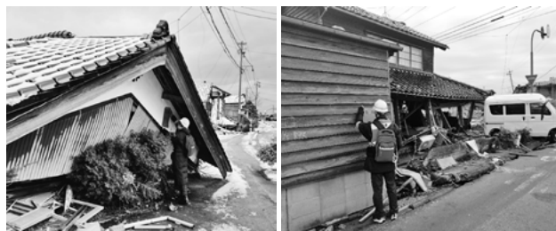
応急危険度判定作業
