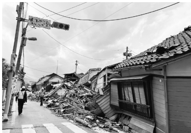
輪島市の被災状況
