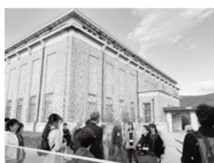
建物内外部に新たな発見あり
