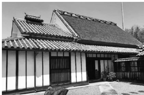
中家住宅 主屋外観
