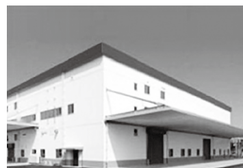
世界最新設備を備えた衛生陶器工場
