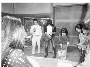
書院保存改修工事現場見学
