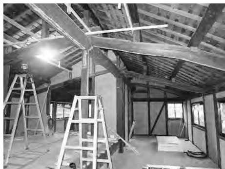
解体した現場
