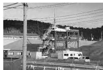
宮城県南三陸町防災庁舎現状
