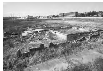
宮城県石巻市津波被災地現状
