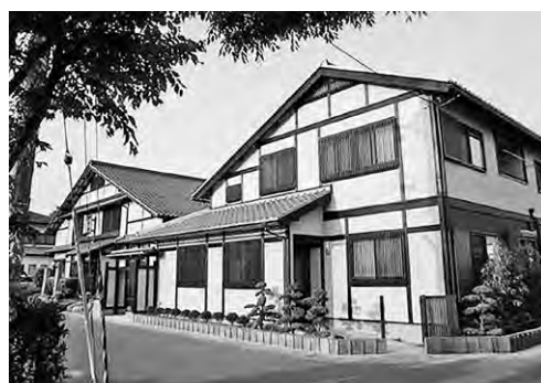
横に建つ母屋と外観を合わせた住宅
