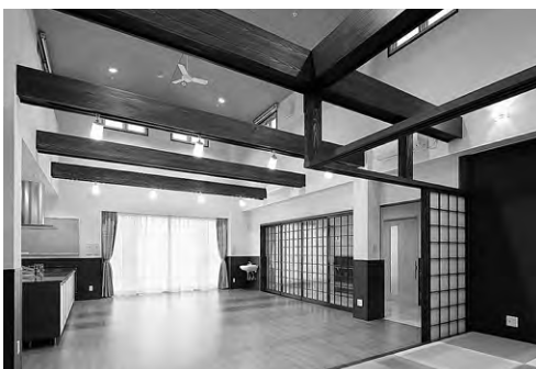
濃い色に着色した梁がアクセントとなった福祉施設の内観
