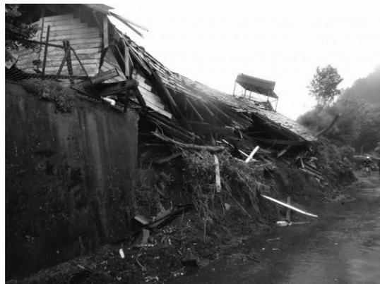
写真4 地盤の崩壊による建物被害2
