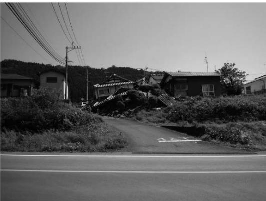
写真3 地盤の崩壊による建物被害1
