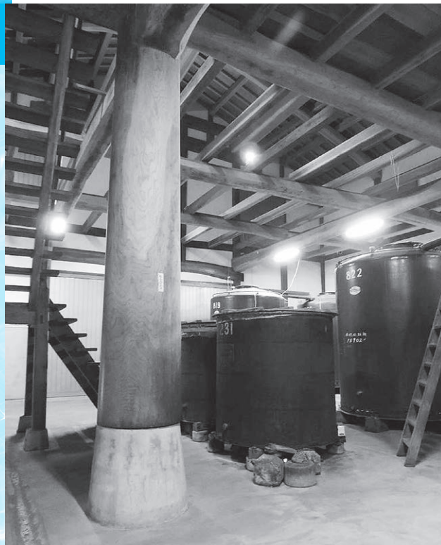
蔵元 藤居本家 東蔵・貯蔵庫
