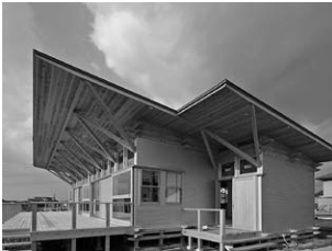
写④ 小径木挟み梁構法による2例目外観
