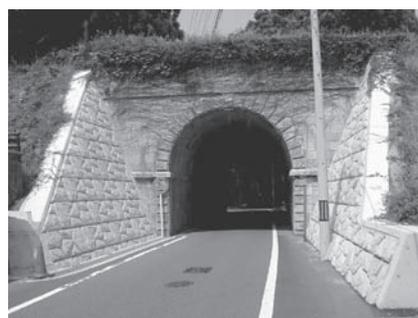
明治17年(1884年)この隧道が完成しました。(日本最初の石造りの道路トンネル 長さ14.6m 幅4.4m)花崗岩の総切石造りの美しいアーチ型のトンネルです。隧道の上の堤防には、樹齢約750年の『弘法杉』(弘法大師が食事をされた箸が杉の木となったと言われている。)がそびえています。湖南省の国道1号線を通る方は一度旧道へ廻りその美しい隧道を見学されてはいかがでしょうか。(小島道雄)
