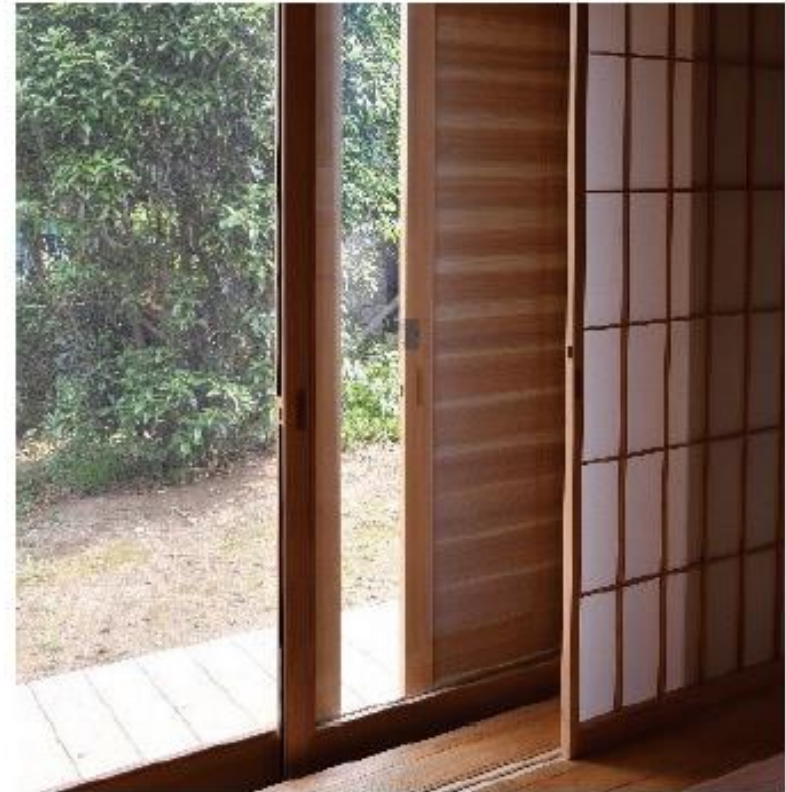
縁側および多層構成の建具の例
