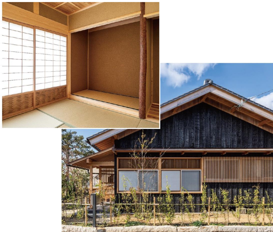
片面真壁造の土塗壁の例
