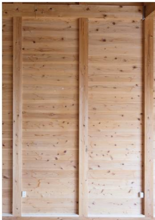
内側落としし込み板現しの例
