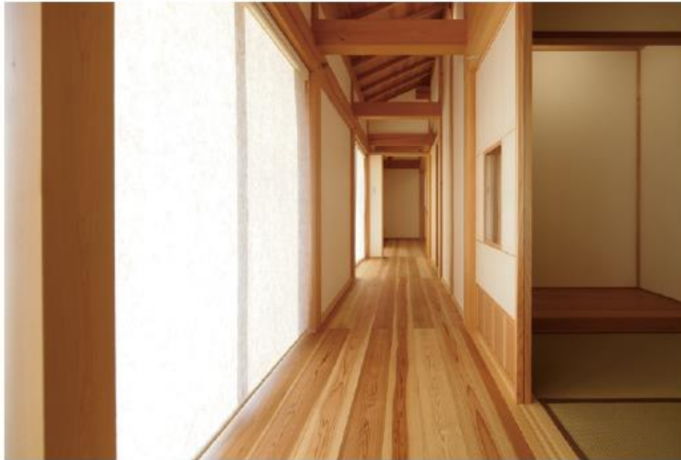
縁側および多層構成の建具の例
