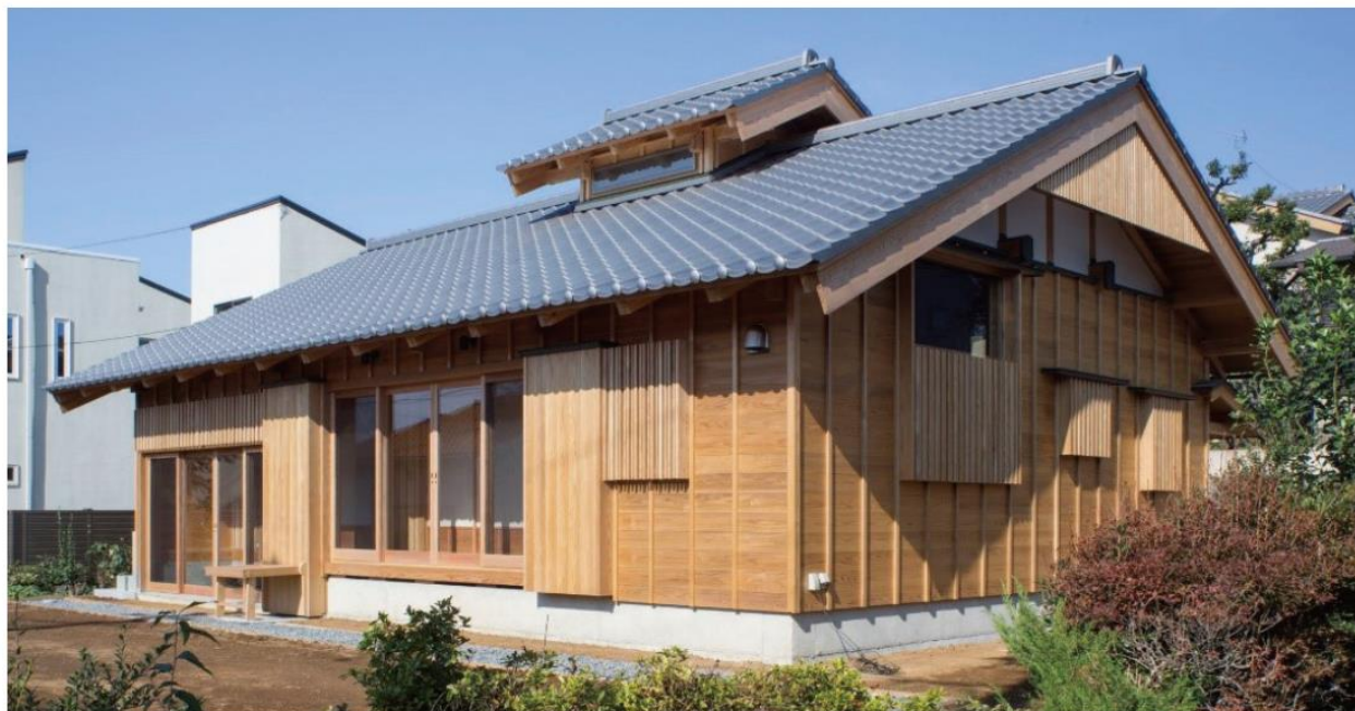
片面真壁造の落とし込み板壁の例
